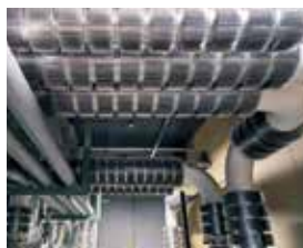
既存設備の配管へあと付け
