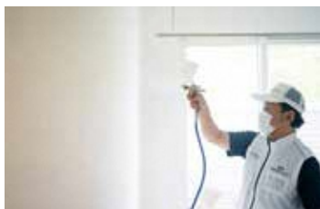
施設・住宅空間にも施工
