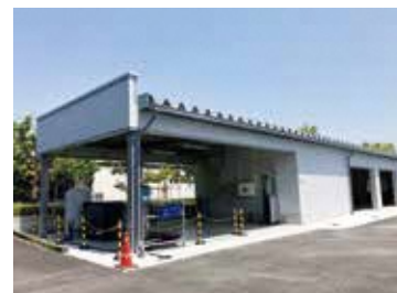
KICKに設置した実証試験施設
