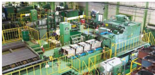
工場に設置された熱間フォーマー
