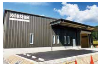
新設した園部工場
