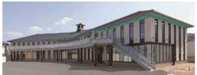
北部産業創造センター外観
