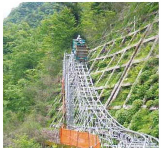
急傾斜地で資材を運搬するモノレール
