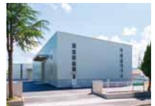
長田野工場敷地内に新設した組立専用工場
