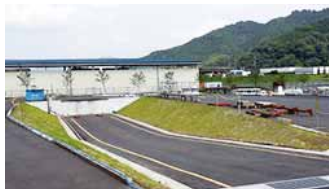
コンテナからの貨物の積み降ろし用の舞鶴工場コンテナデバンヤード
