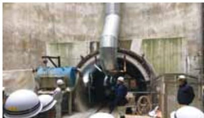
ている北幹線と貫通したことから全長9.2kmにおよぶ地下トンネルがつながりました。地下トンネルの終着点である同事務所洛西浄化センター内の発進立坑から地下27mを仮設階段で降り、内径3.5mのトンネル内を見学しました。今後、同地に呑龍ポンプ場が
