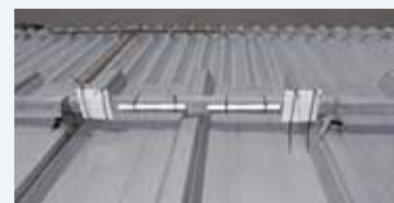
写真1 試料の屋上設置状況例(樹脂種:POM)
