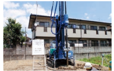
今回導入した地盤改良用重機
